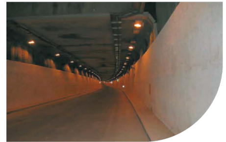
"CIRCONVALLAZIONE NORD" TUNNEL LINING - ROME
