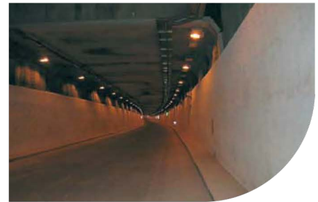
"CIRCONVALLAZIONE NORD" TUNNEL LINING - ROME
